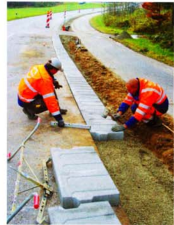
Die neuen Betonbankettplatten an der Kreisstraße AÖ2 haben den Härtetest zwischenzeitlich bestanden. Auch wichtig: Das Relief auf der Oberseite macht müde Autofahrer rechtzeitig munter
